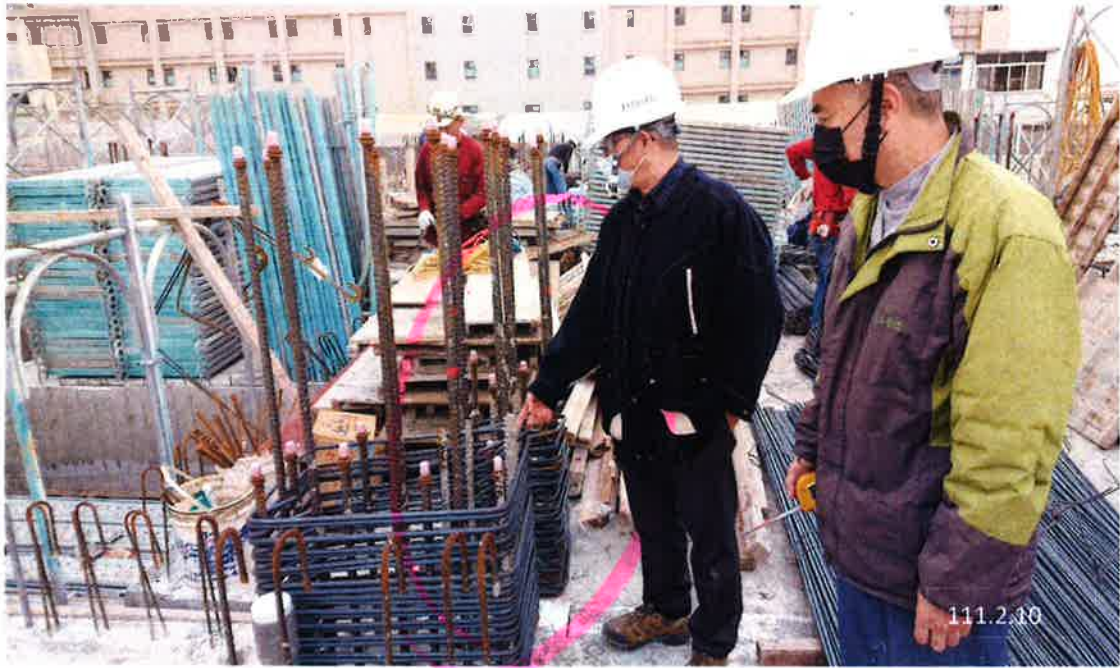
上圖:3 樓柱筋有混凝土殘留現象，請改善
