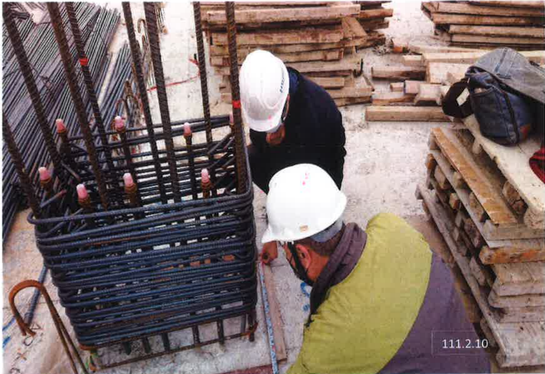
上圖:3 樓柱放樣尺寸放樣檢核情形
