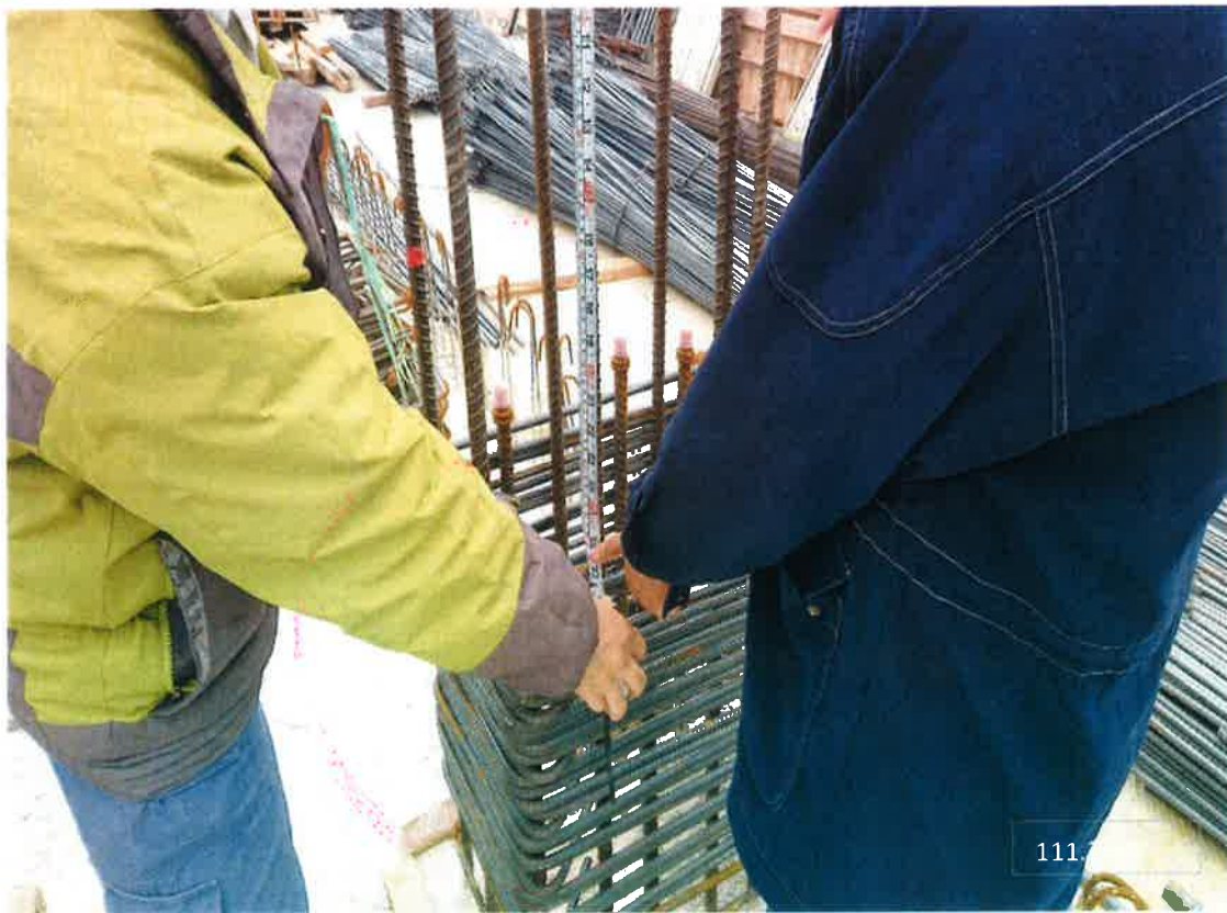
上圖:3 樓柱筋續接接器錯搭位置檢核情形
