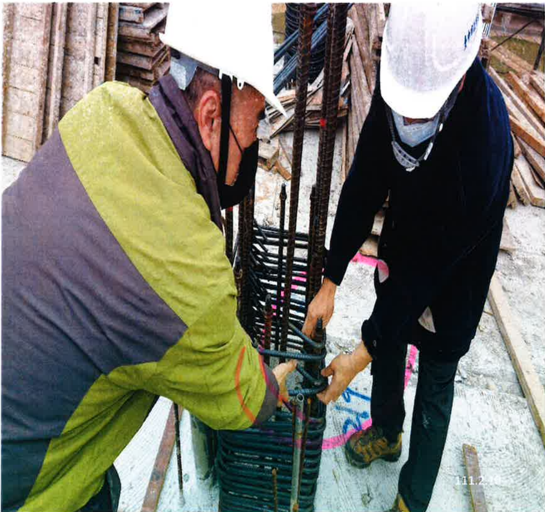
上圖:3 樓柱箍筋彎鉤同一側且未有交錯置放現象，請改善
